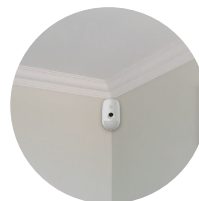
Déclenchement de l'alarme
